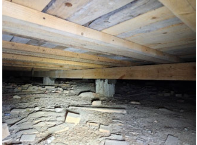
Kuva 2. Uusittu puurakenne.
