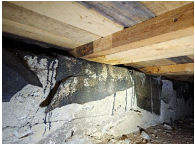
Kuva 4. Uusittu puurakenne.
