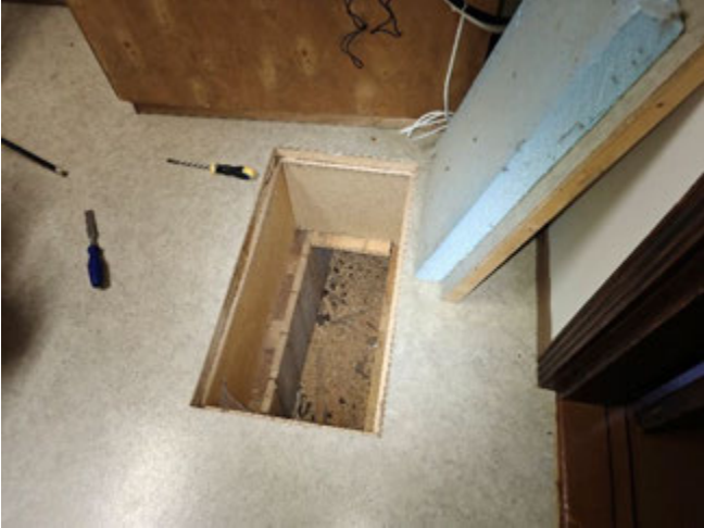
Kuva 1. Ryömintätilan luukku.
