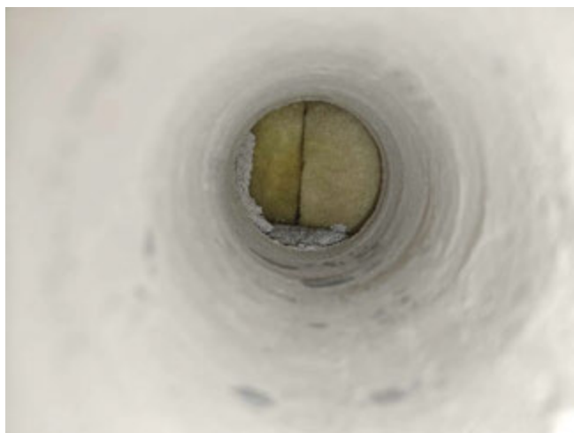
Kuva 14. Maanvastainen seinään tehty rakenneavaus, MS1.2.
