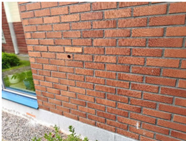
Kuva 25. Ulkoseinään tehty rakenneavaus, US1.8.
