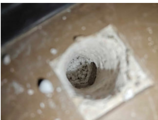
Kuva 19. Alapohjarakenteeseen tehty rakenneavaus, AP1.2. EPS-eriste näkyvissä.
