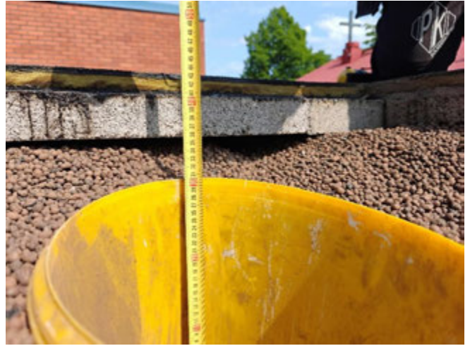
Kuva 29. Yläpohjarakenne.
