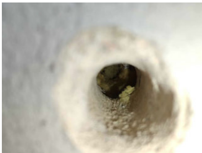
Kuva 10. Sokkeliin tehty rakenneavaus, SK1.2.
