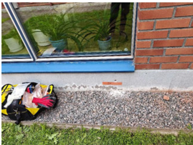
Kuva 9. Sokkeliin tehty rakenneavaus, SK1.1.
