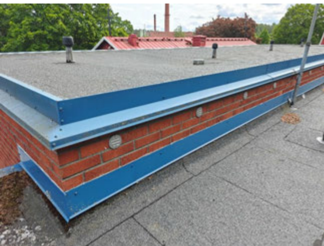
Kuva 32. Yläpohjan tuuletus.
