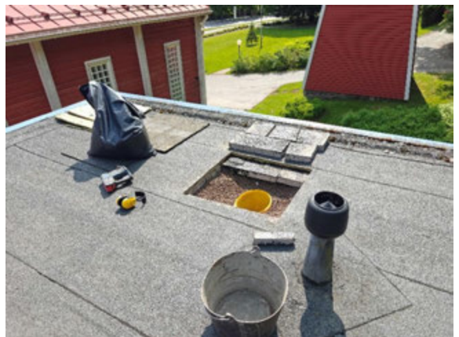
Kuva 33. Yläpohjan tuuletus.
