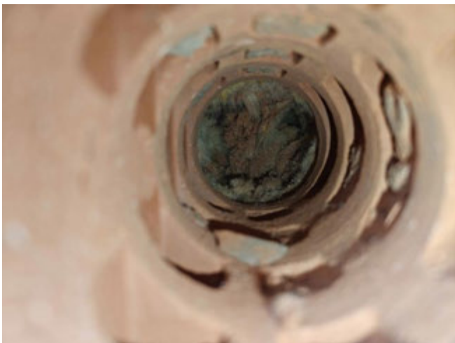
Kuva 24. Ulkoseinään tehty rakenneavaus, US1.6.
